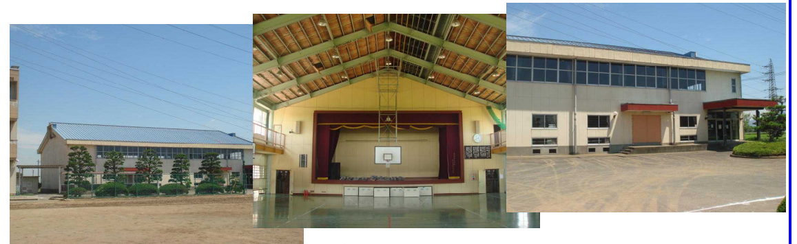
工事前の体育館（全景、内部）
